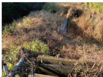
台風被害による被害箇所の復旧
