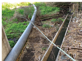
御成橋下の下水管整備
