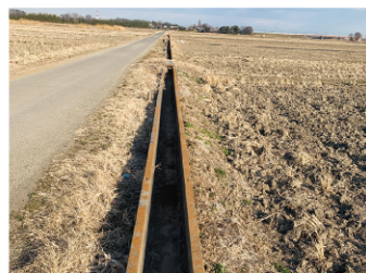
堤外水路整備
