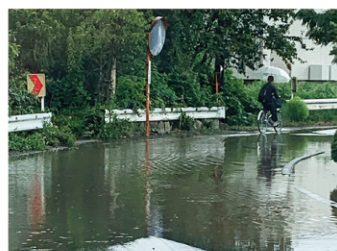
一般道路の修繕・補修
