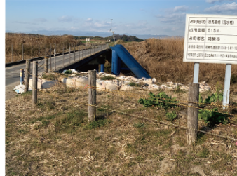
原馬室橋等整備
